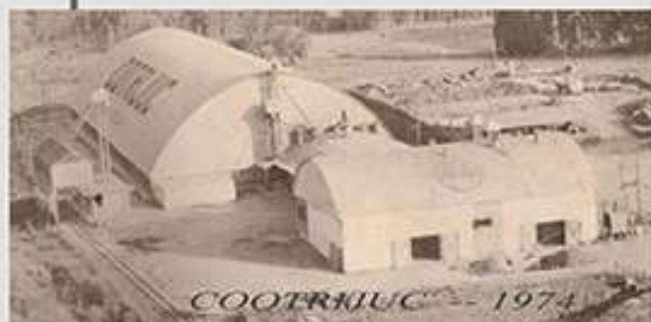
Estruturas de armazenagem de grãos da Sede, em 1974.
